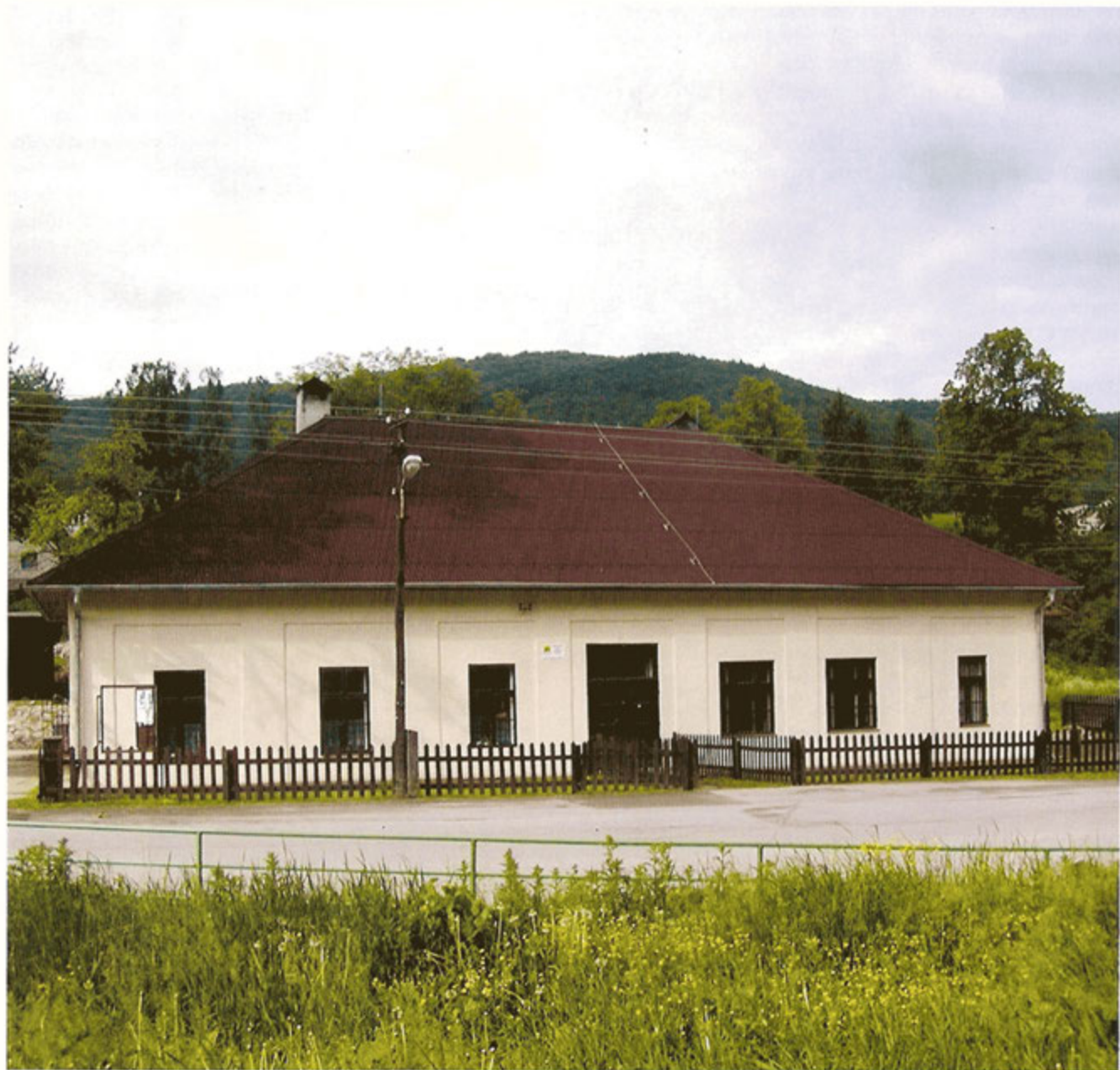
Lesovňa Košická Belá po rekonštrukcii
