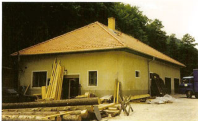
Budova stolárskej dielne v Čermeli po rekonštrukcii
